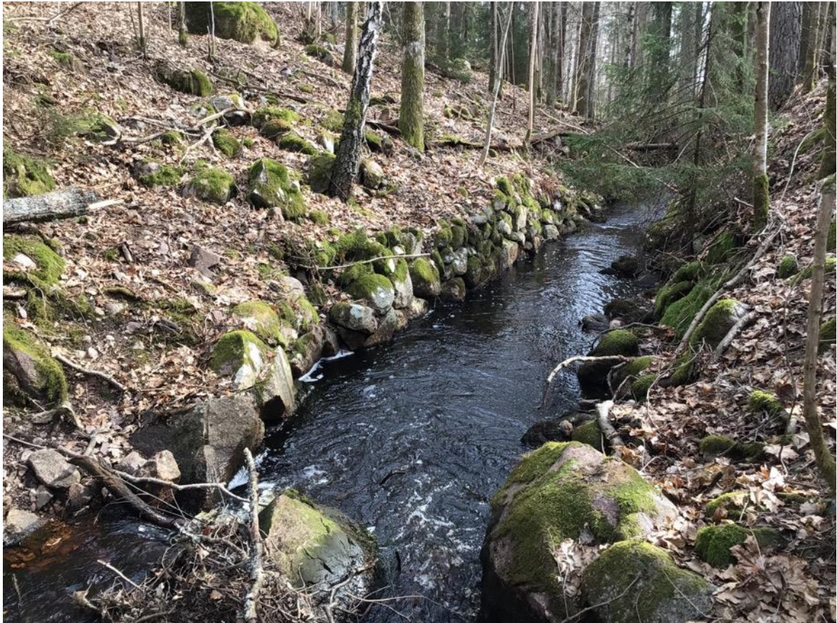
Figur 8. Här syns nuvarande kraftigt fördjupade utlopp från Tarmlängen som både är grävt, sprängt och även delvis stensatt.
