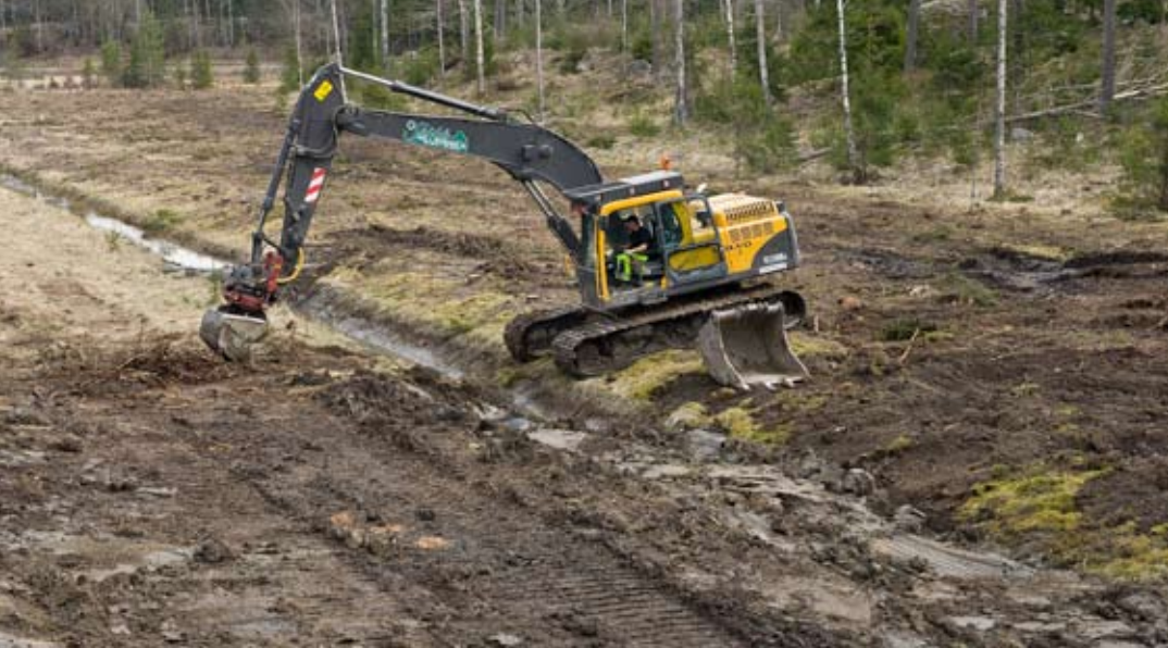
Igenläggning med bandgående grävmaskin.
