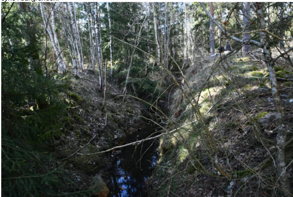
Den övre delen av vattendraget efter Imbramåla göls utlopp är kraftigt fördjupat.
