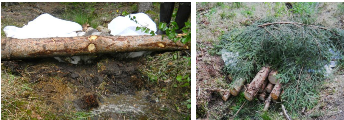
Figur 6. Exempel på hur en dikespropp kan se ut. Foto: Torsås kommun. Man kan använda sig av stockar, sten och lera. En kombination av detta är ofta att föredra för att göra dämnet stabilt.
