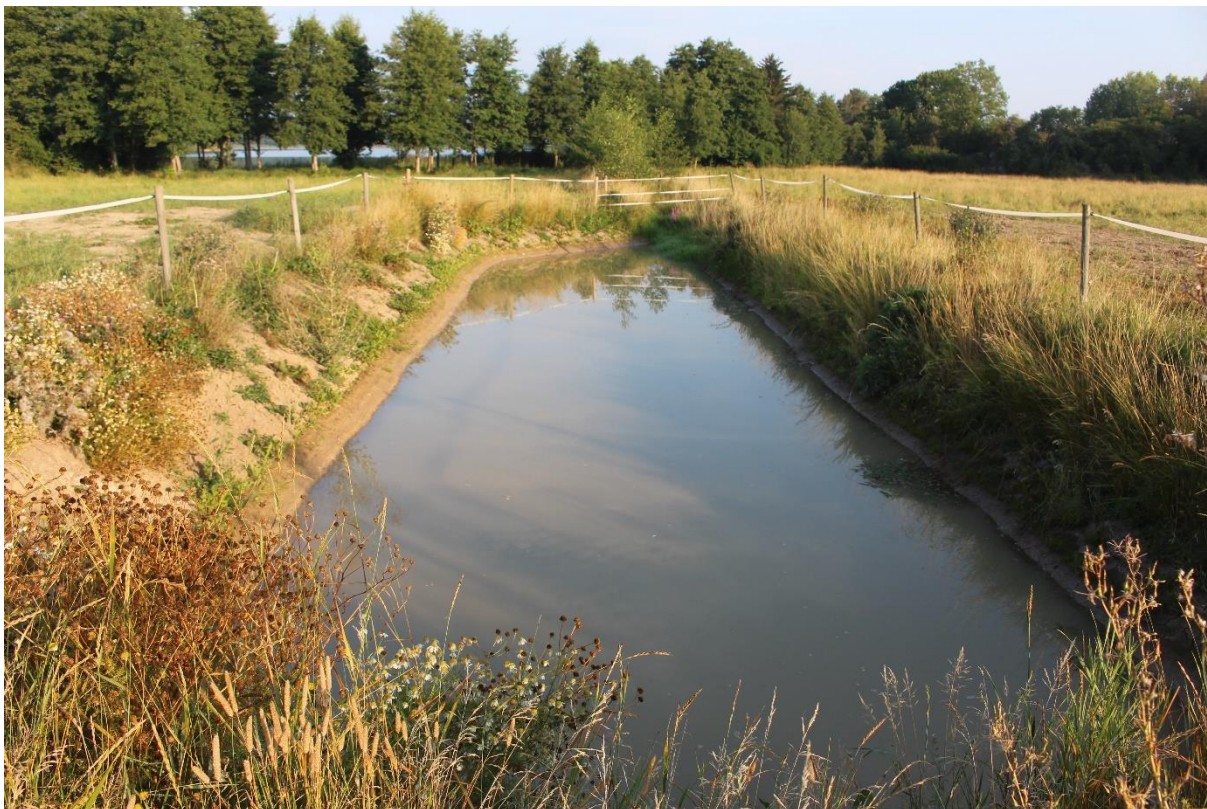
Figur 15. Exempel på sedimentationsfälla/fosforfälla. Foto: C-J Natur
